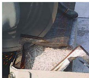
VIGAS DE HIERRO
